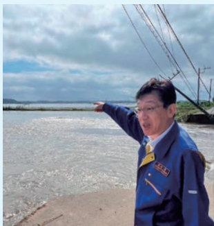
栄町の破堤部を視察
